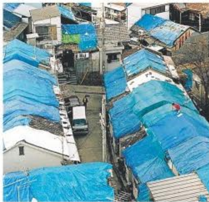
阪神・淡路大震災の被災地で目立ったブルーシートの屋根
